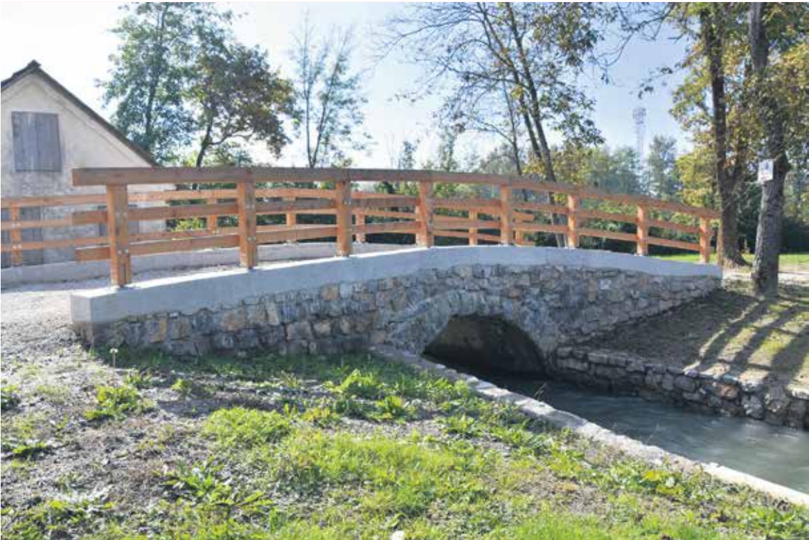
Most po sanaciji oktobra 2025
