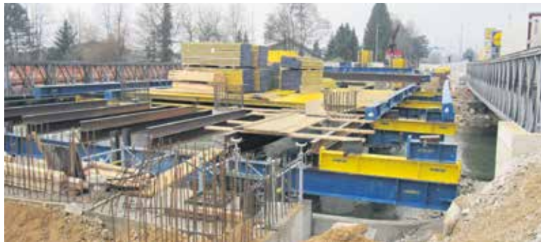
Začasni podporni piloti bodo ob koncu gradnje odstranjeni.
